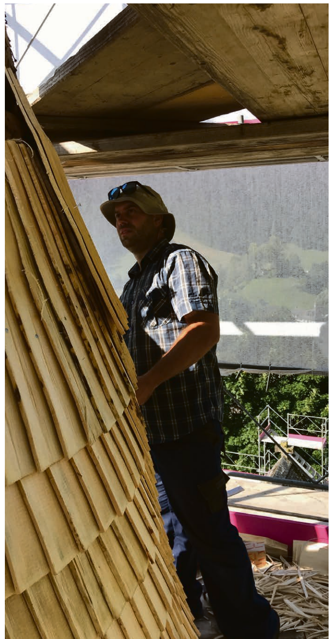
L'église de Rossinière est sous toit.
